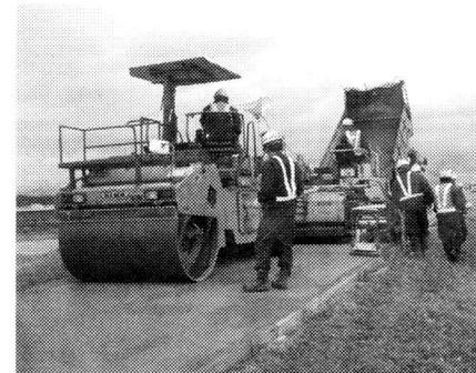
再生骨材を使用してRCCP
