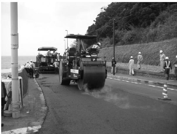
図9 国道28号線での試験舗装 (2009年2月)
