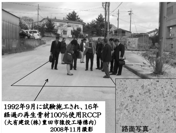
図8 再生骨材使用転圧コンクリート舗装例
