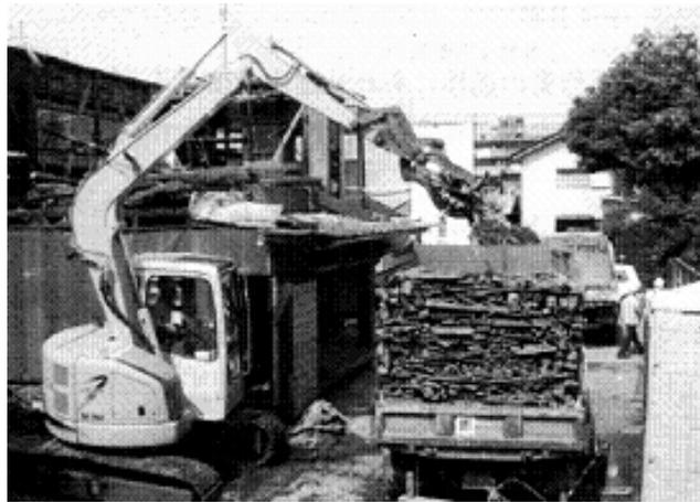
写真8-3 分別された建設発生木材の積み込み<sup>1)</sup>
