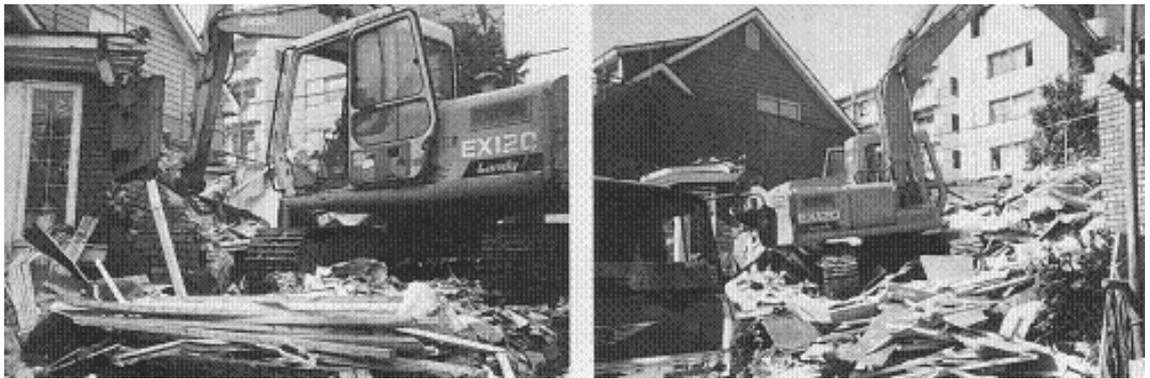
写真8-2 機械による分別解体<sup>2)</sup>
