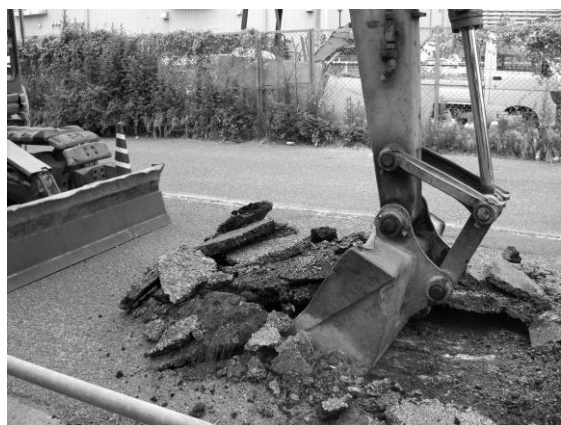
写真5-5 バックホウによるアスファルト混合物層のはぎ取り
