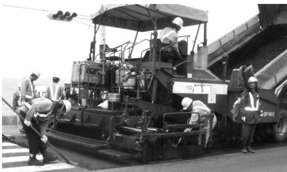
写真5-1 アスファルトフィニッシャーによるアスファルト混合物の敷きならし
