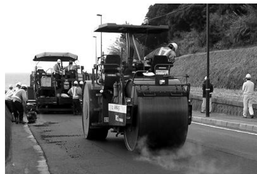
写真5-2 敷きならしたアスファルト混合物をローラにより転圧
